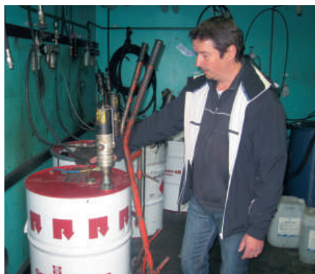
Бочки с материалами и насосами вынесены в отдельное помещение.
